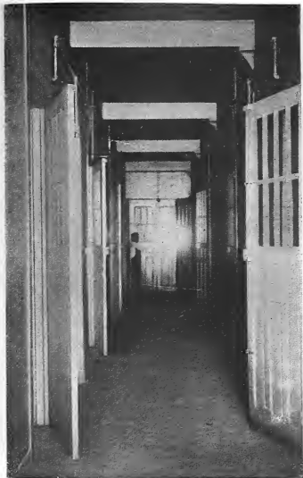
FIG. 26. — Couloir central des ateliers.
